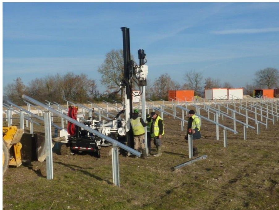
Photo 100 : Mise en place de support de panneaux
