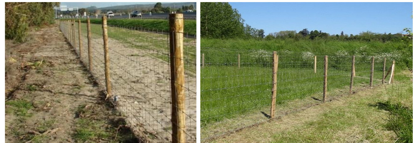
Photo 99 – Exemples de clôtures à favoriser en lisière de parcelle (vocabulaire agricole et naturel)
