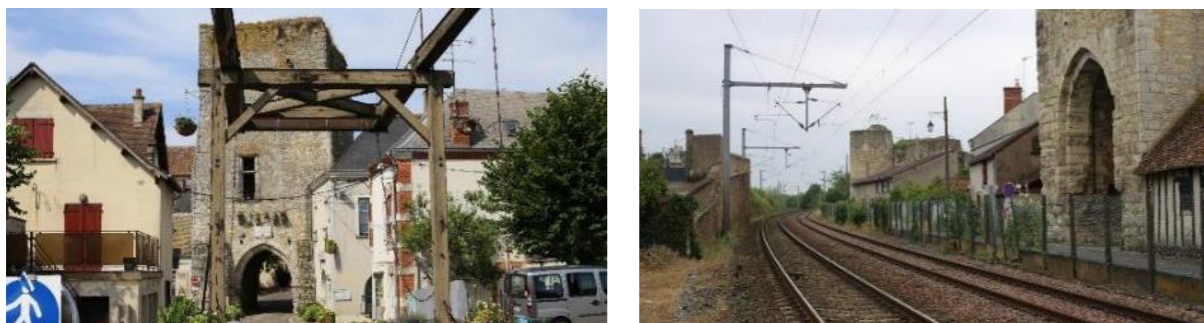
Photo 59 : Tour sud au pied du canal de Berry à gauche ; voie ferrée au pied du coteau à droite
