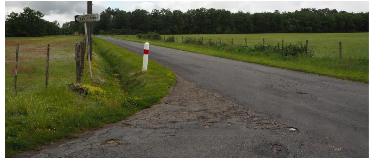
Photo 30 : La RD123 vue depuis la voie communale d'accès au hameau les Barres (source : AEPE Gingko)
