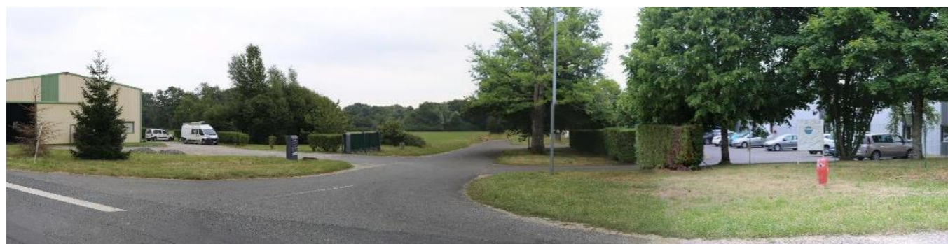
Photo 81 : Abords arborés de l'entrée de la zone d'activités du Gaudet et du futur parc photovoltaïque
