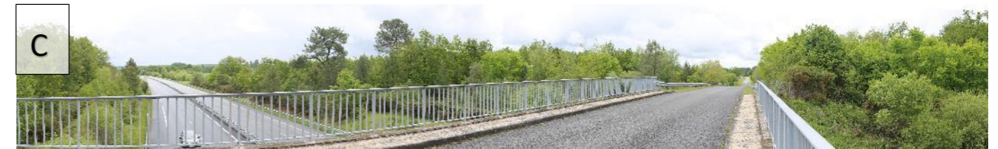
Photo 67 : L'aire immédiate perçue en surplomb depuis le franchissement de la RD123 au-dessus de l'A85.
